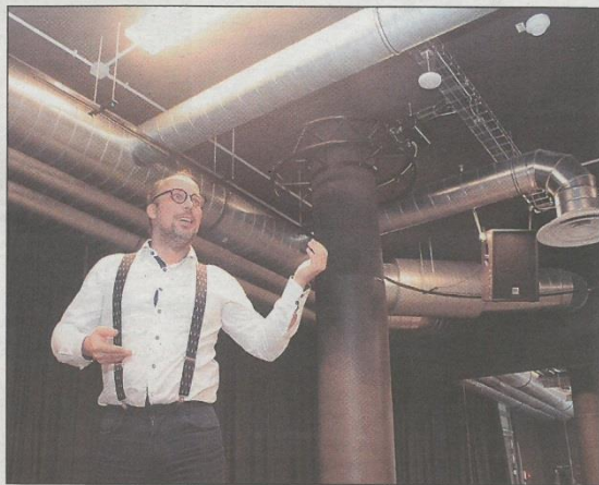
ŘEDITEL Horáckého divadla Ondrej Remiáš pod vřetechoteknikou, rampami a světlý v nové velké zkušebně. Tu vznikla v prostoru někdejší divadelní restaurace v prvním patře budovy. Foto: Jiří Varhaník
